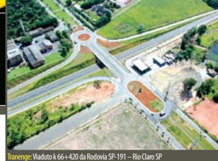
Tranense: Viaduto k 66+420 da Rodovia SP-191 – Rio Claro SP
