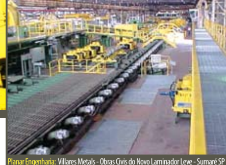
Planar Engenharia: Villares Metals - Obras Cíveis do Novo Laminador Leve - Sumaré SP
